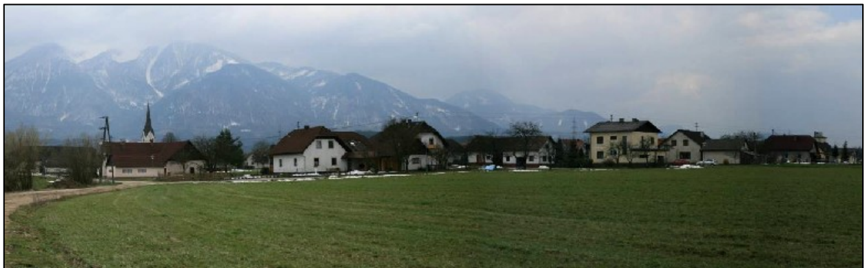
Hof – Blick Richtung Südsüdwest
